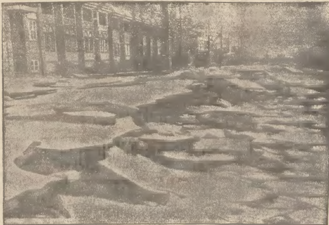
(—) Szalejący na wybrzeżu atlantyckim orkan rozerwał w strzępy jezdnię asfaltową na Atlantic City koło Nowego Yorku.
