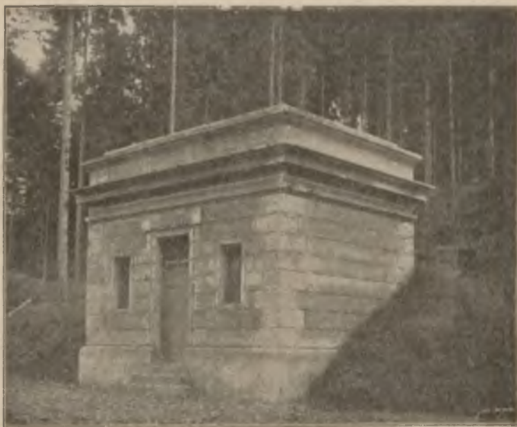
Zbiornik wodociągu w Krynicy.
