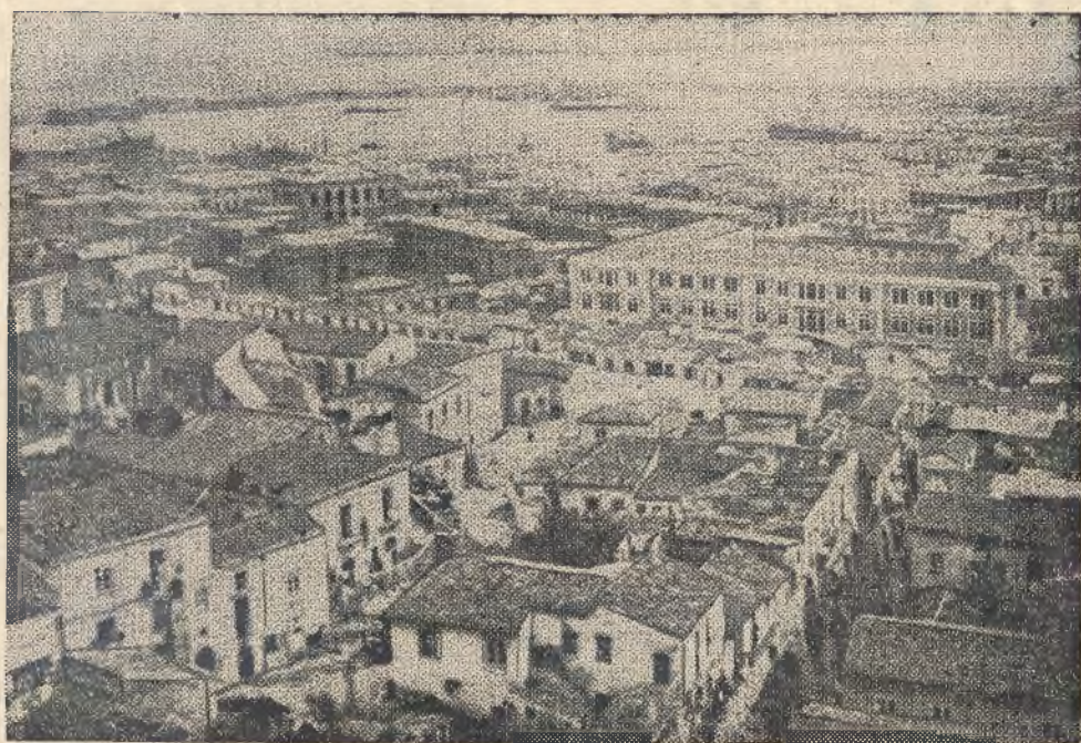
Ogólny widok Messyny.
