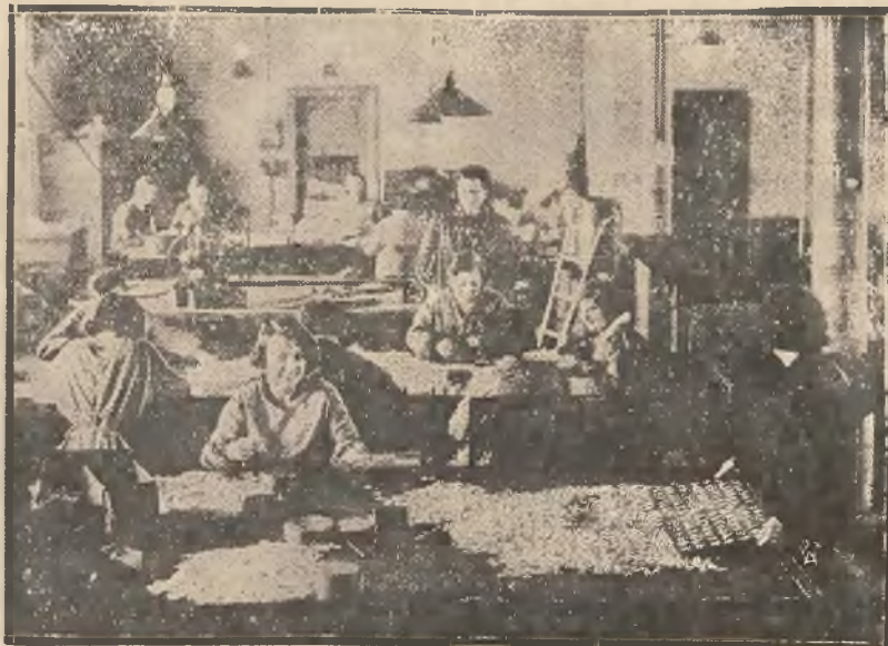
Ostatnią fazą bicia monet w mennicy jest sprawdzanie ich tak co do jakości wykonania, co do wagi i dźwięku. Czynności te wykonuje kilkadziesiąt osób. — Na zdjęciu naszym widzimy jedną z sal mennicy warszawskiej, w której kilkanaście pracowników bada wybite monety.
