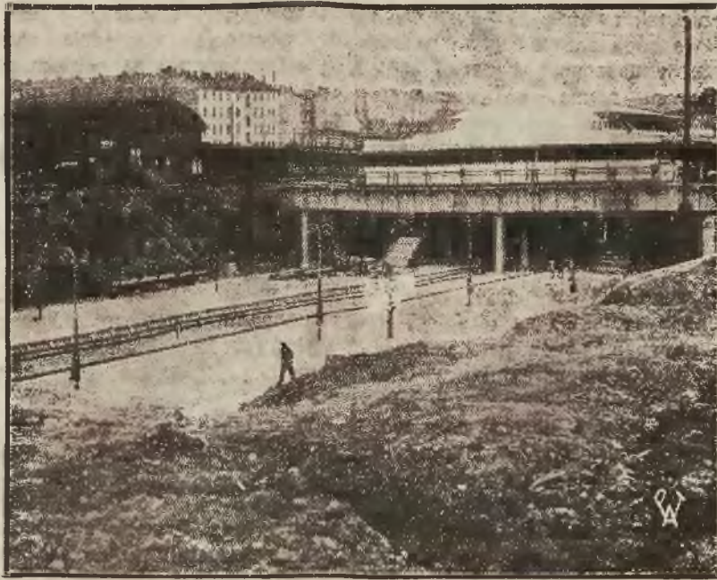
Widok na nowy tymczasowy dworzec średnicowy w Warszawie po zburzeniu okalającego go w Aleji Jerozolimskiej. Widoczne są podjazdy po obu stronach odkrytego tunelu oraz perony betonowe, na których ustawiono już 4-ramienné wysokie latarnie elektryczne. Tory na tem miejscu są całkowicie wykończone.
