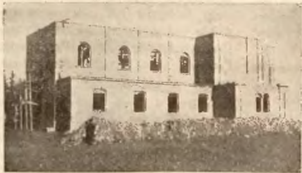
Stan budowy Kościoła w Świtarzowie w dniu 1. X. 1938 r.
