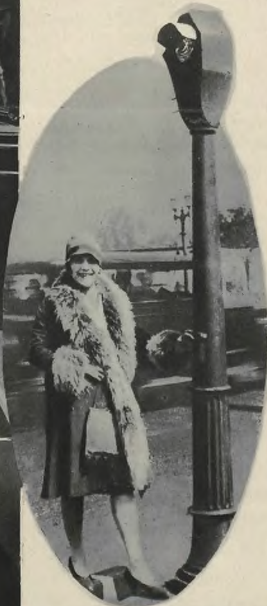
Sygnal uliczny w Los Angeles, który każdy przechodzień sam obsługuje. Za przyciśnięciem guzika jezdni się zamyka i równocześnie zostaje oświetlona czerwonym światłem.
