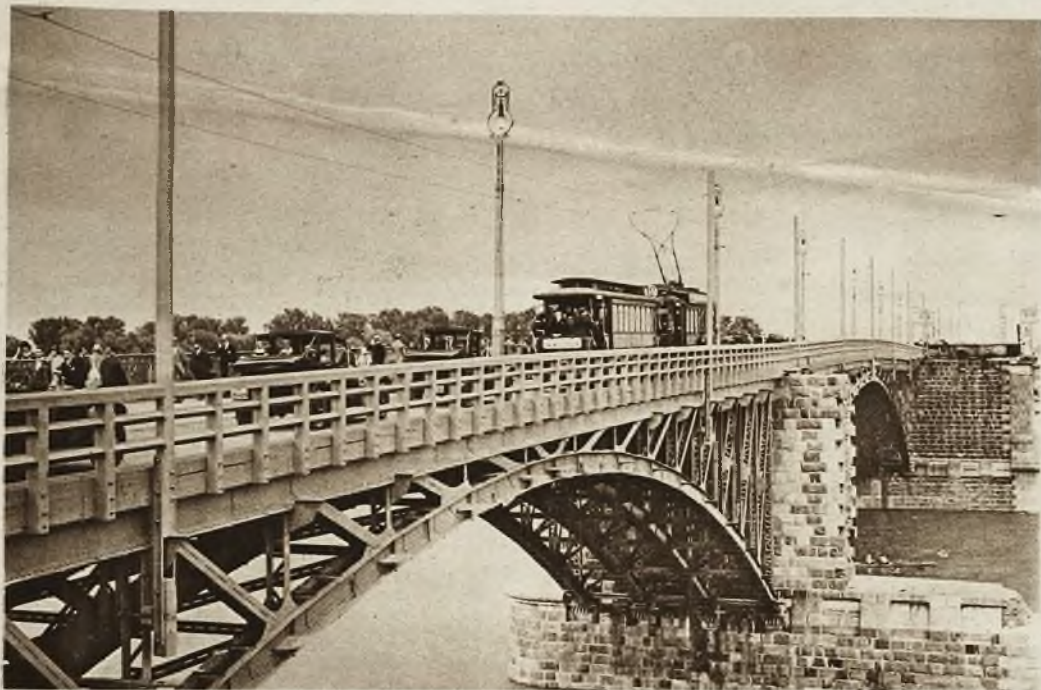
W Warszawie dokonano odbudowy mostu Poniatowskiego zniszczonego przez Niemców. Pełczyński
