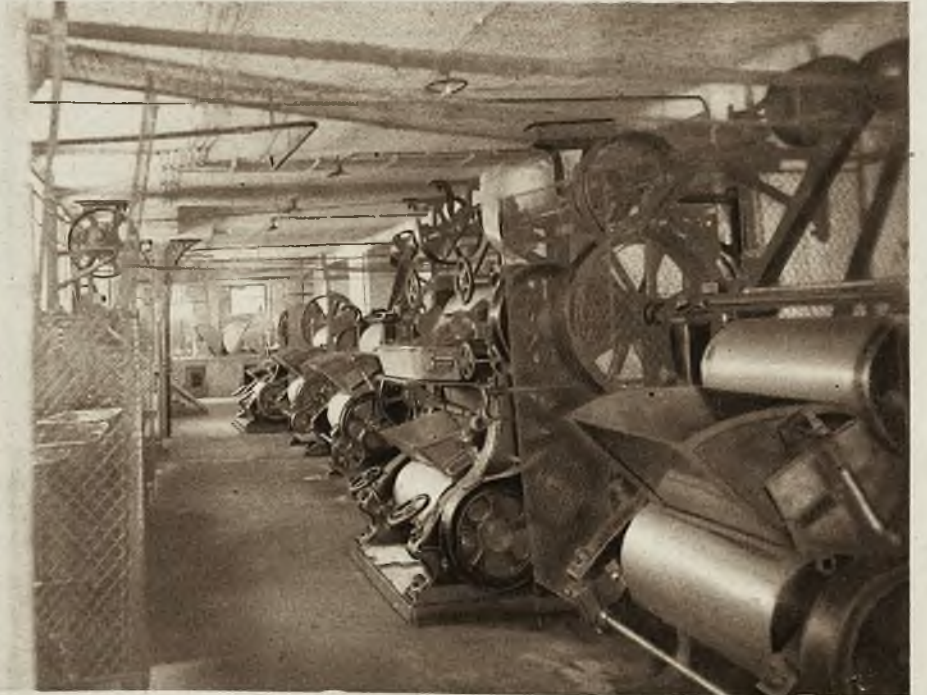
Hala maszyn (Wałce stalowe i granitowe)
