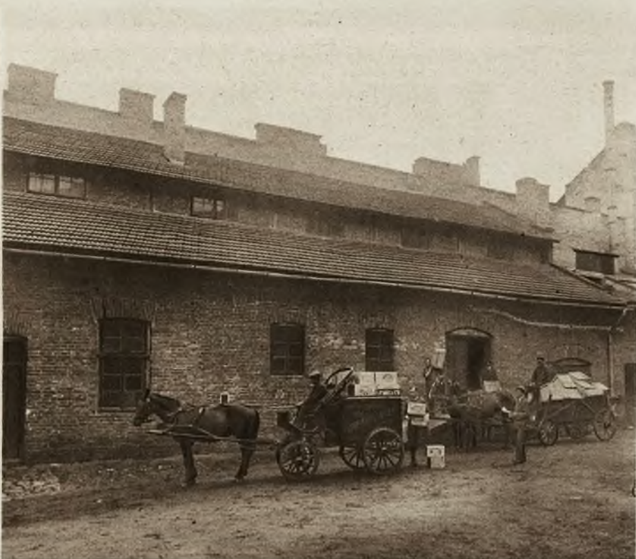
Budynki gospodarcze i magazyny
