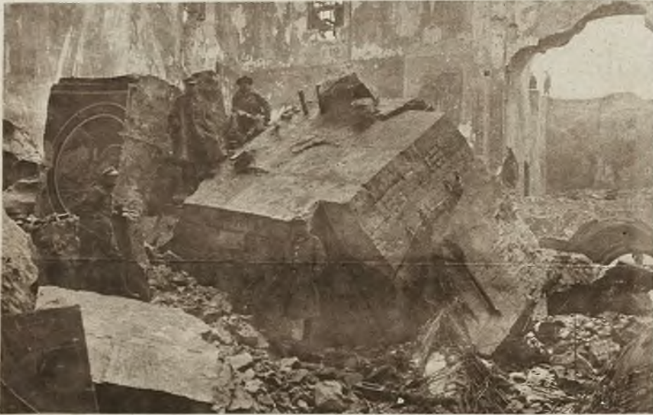
Dla przyspieszenia rozbiórki soboru na Placu Saskim, postanowiono przy pomocy materiałów wybuchowych zwalić 4 kolumny granitowe i tym sposobem podważyć sklepienie. Zdjęcie nasze przedstawia granitowe bryły sklepienia, zwalone wybuchem, leżące na wysokość paru pięter na posadzce soboru.
