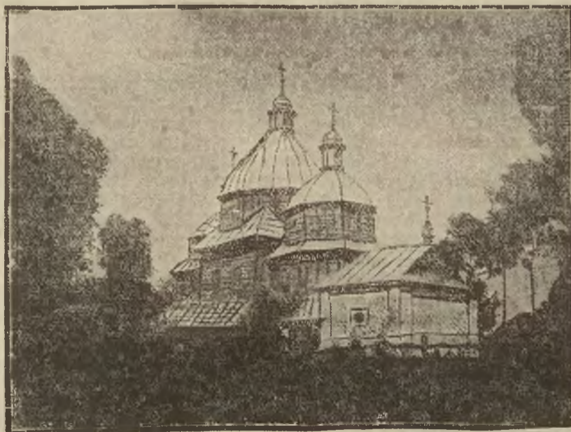
Na zdjęciu widzimy cerkiew Św. Trójcy w Żółkwi, zbudowaną w r. 1601 z drzewa modrzewiowego.
