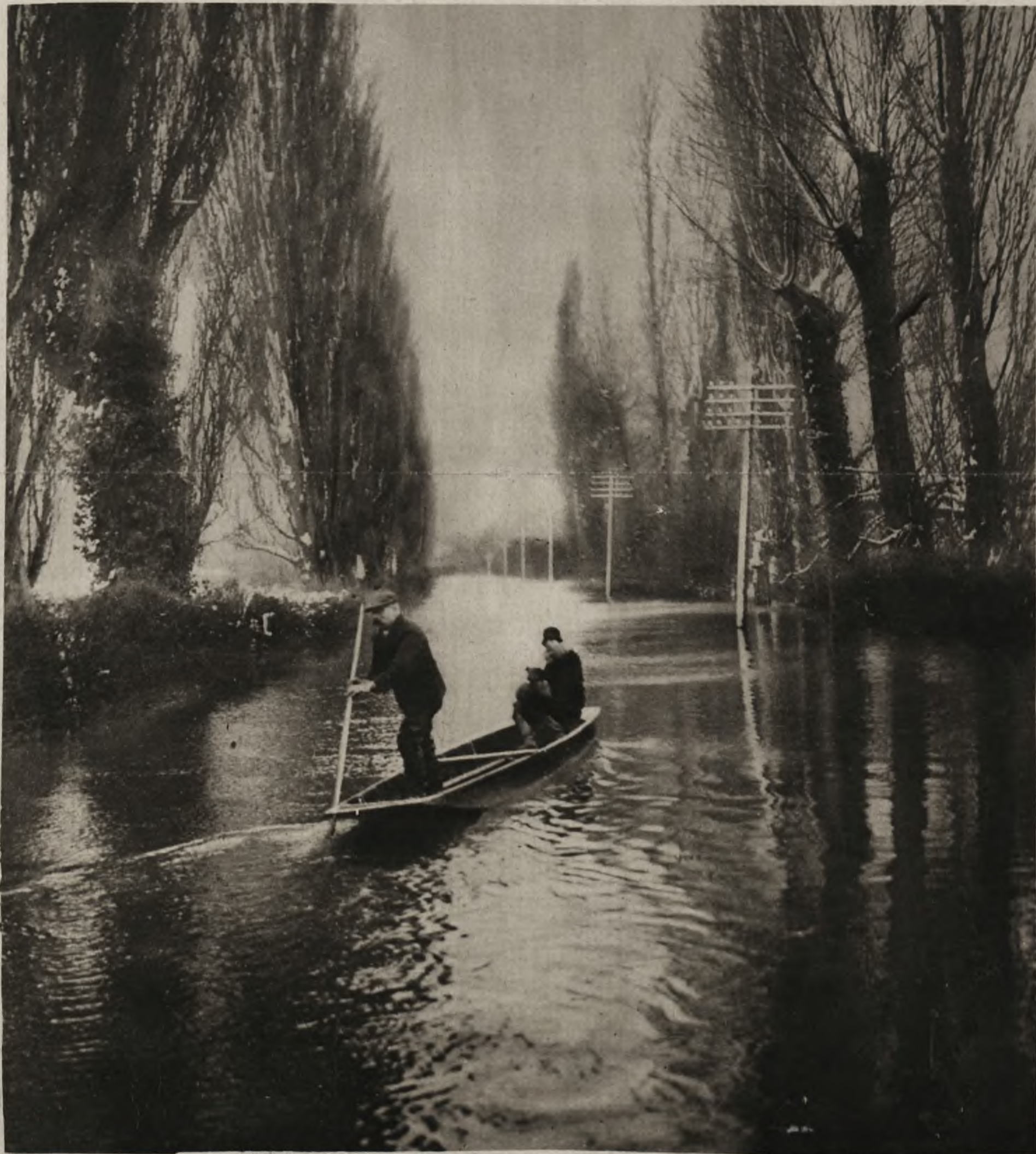
Mimo niezwykle ostrej zimy wiele krajów południowej i zachodniej Europy uległo katastrofalnym powodziom. Do najbardziej dotkniętych należy Anglja. Zdjęcie nasze przedstawia drogę prowadzącą z Shepperton do Londynu, znajdującą się metr pod wodą.
