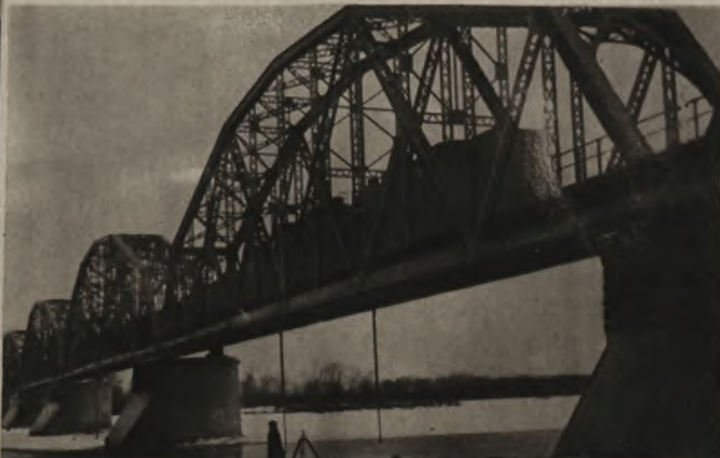
Dnia 11 b. m. nastąpiło otwarcie mostu kolejowego pod Sandomierzem w obecności p. mln. kolei P. Romockiego. Most zbudowany jest na kesonach, jest stalowej konstrukcji o 6 przęsłach łącznej długości 450 m. Jest to pierwszy stały most kolejowy wybudowany w Rzeczypospolitej przez robotników i inżynierów Polaków.
