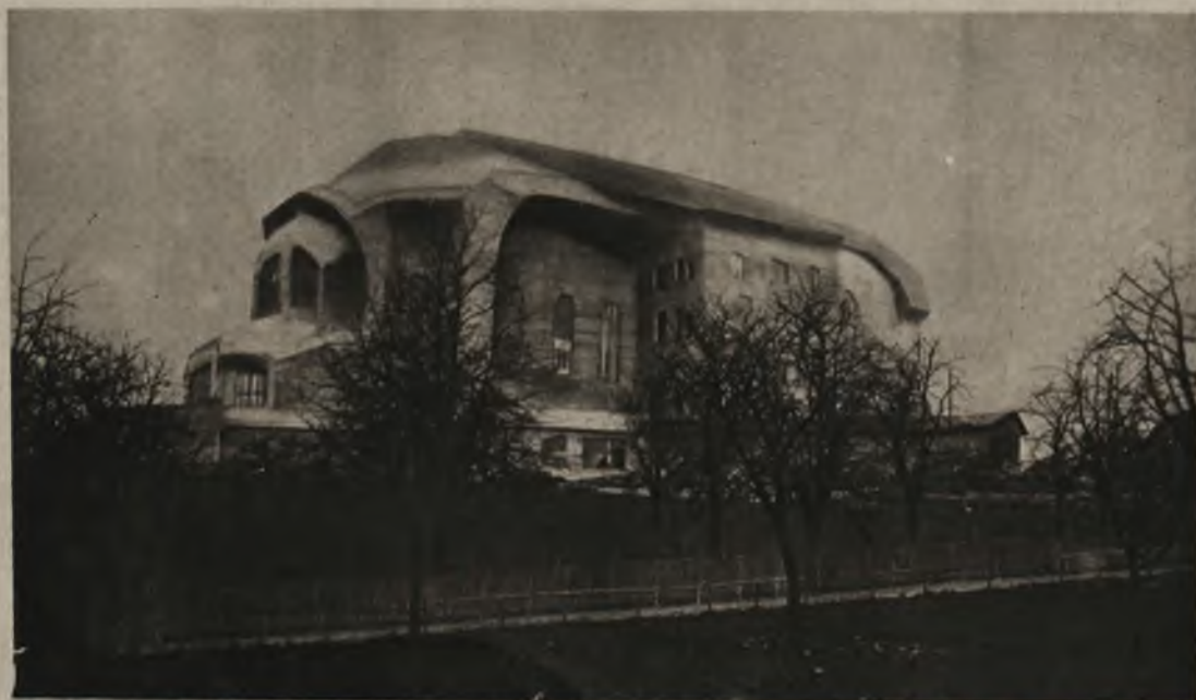
W Bazylei wzniesiono budynek Goetheanum, na miejscu dawnego drewnianego budynku, który spłonął 1925 r. Nowy budynek jest zbudowany z bloków betonowych.
