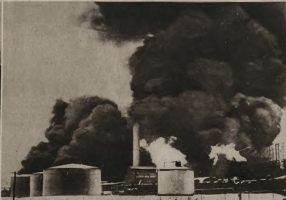
Pożar dwu ogromnych zbiorników nafty w Ewerett (Ameryka Północna, stan Massachusetts).
