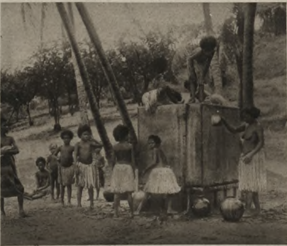
Na Nowej Gwincei zbudowano dla użytku krajowców tanki metalowe, które gromadzą wodę deszczową. Brak wszelkich źródeł powoduje, że woda deszczowa jest wysoko ceniona.
