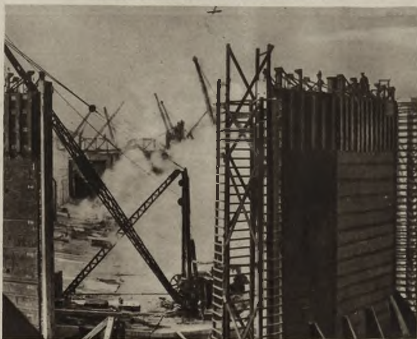
Budowa olbrzymich doków pływających w Tilbury (Anglija).
