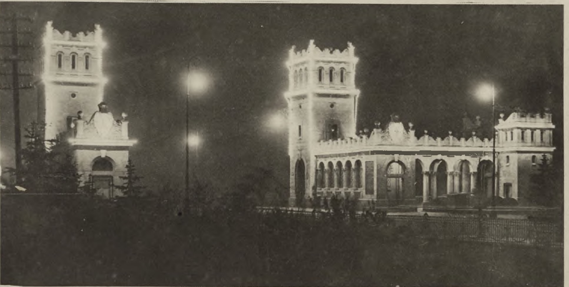
Iluminacja mostu ks. Poniatowskiego wraz z wiaduktem.
