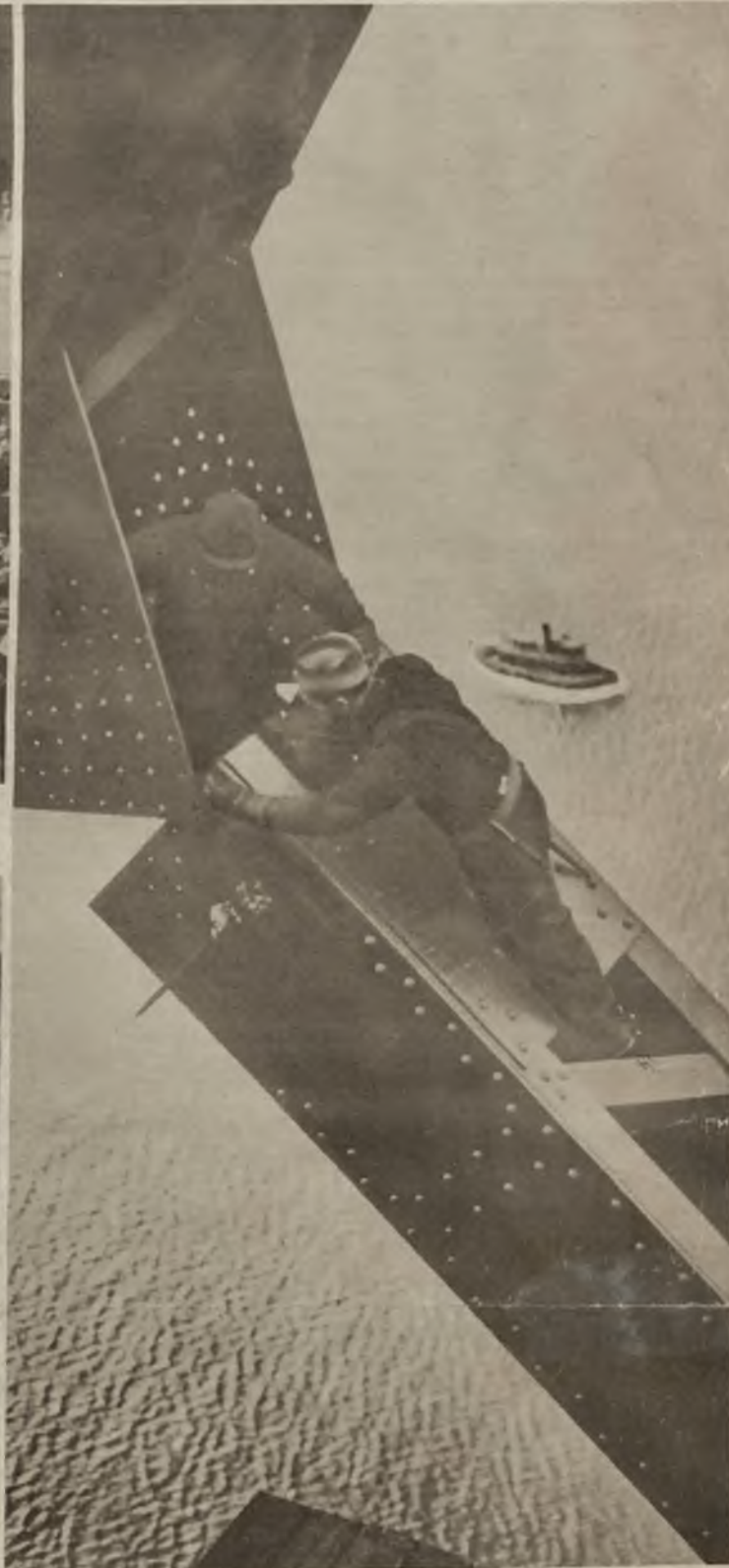
Niebezpieczne montowanie mostu na rzece Hudson na wysokości 400 m. W dole widoczny parowiec, przedstawiający się z tej wysokości jak dziecinną zabawkę.
