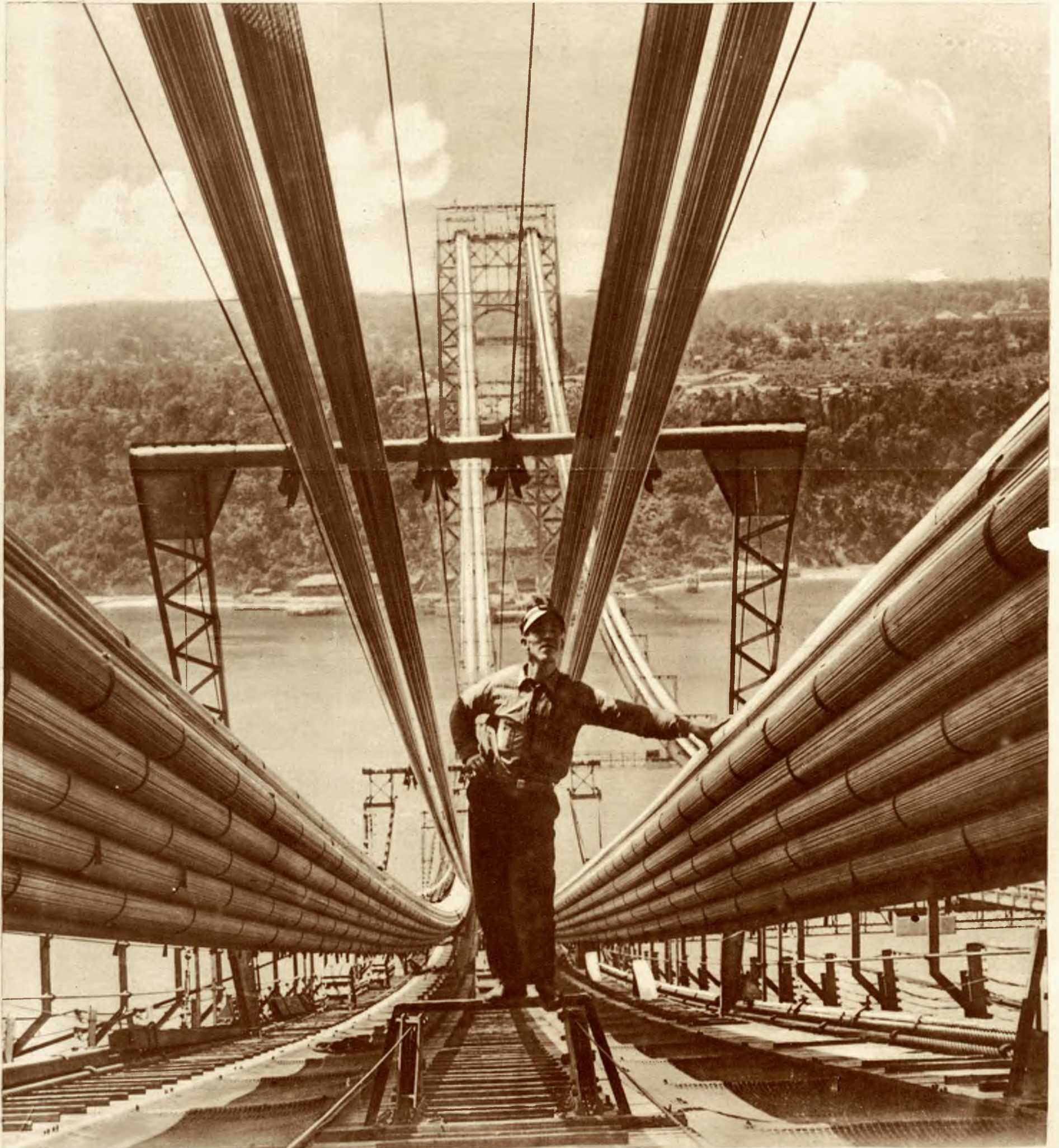
Nowy most wiszący N. Jork—Hudson, swemi niezwyklejmi rozmiarami budzi sensację. Kable nośne składają się z lin stalowych długości 120.000 km. 4 główne kable łączone są z 434 lin każdy. Rozpiętość mostu wynosi 1200 m.
