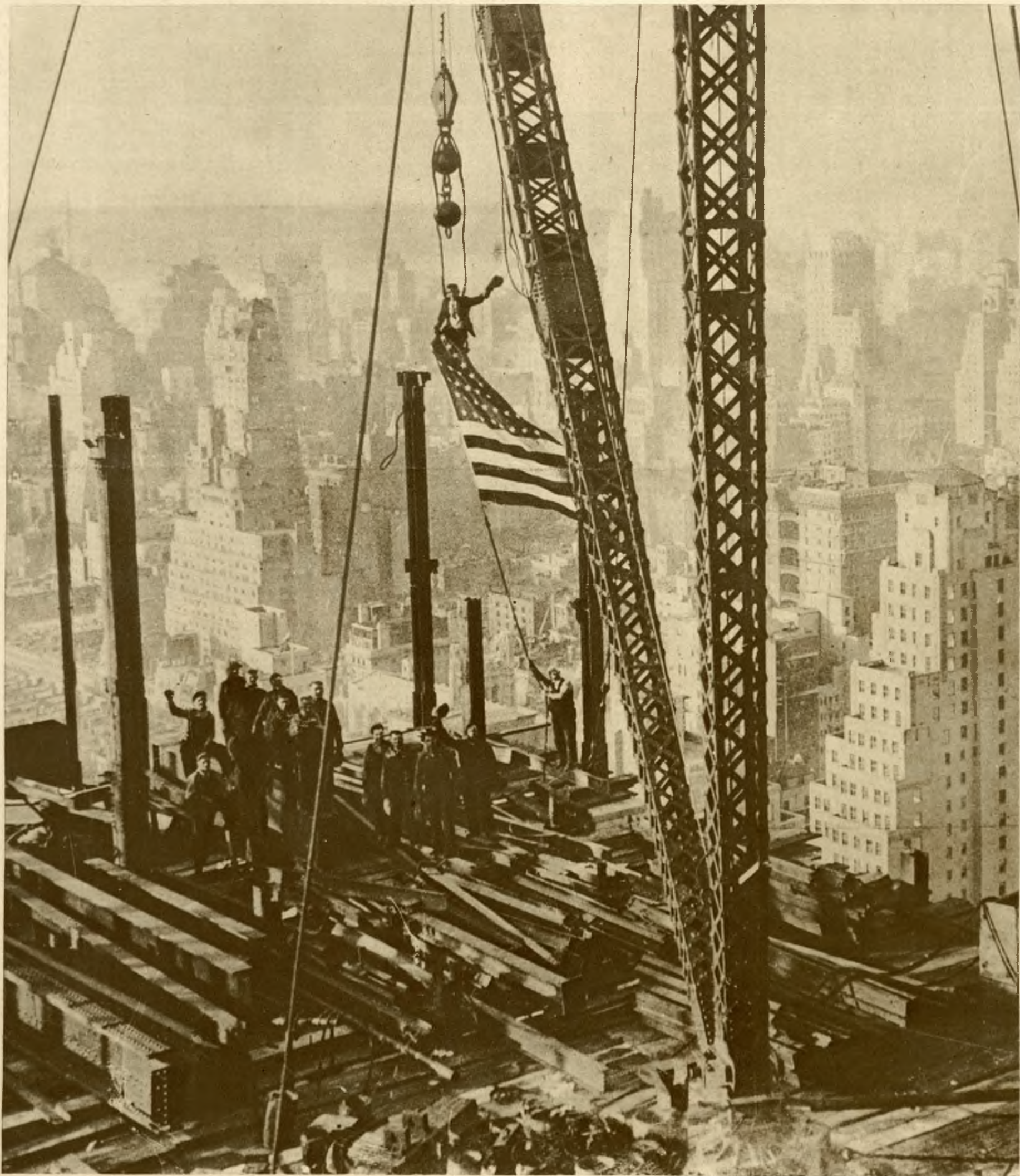
Robotnik w trakcie umieszczania flagi amerykańskiej na szczycie nowo wybudowanego hotelu Waldorf-Astoria w N. Jorku, co jest oznaką, że roboty około budowy zostały ukończone.
