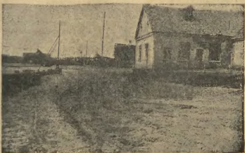
Głębokie piachy na ul. Wodociągowej i opuszczone domostwa.
