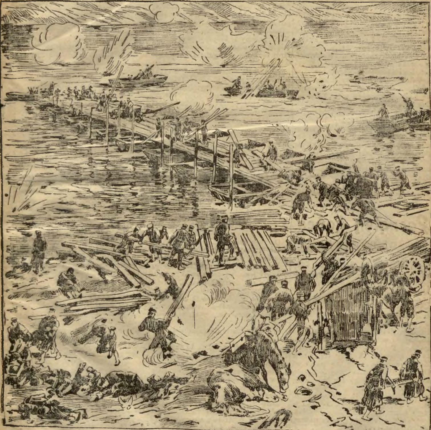
Japończycy budują most celem przejścia przez rzekę Jalu, narażeni na silny ogień z fortyfikacyj rosyjskich
