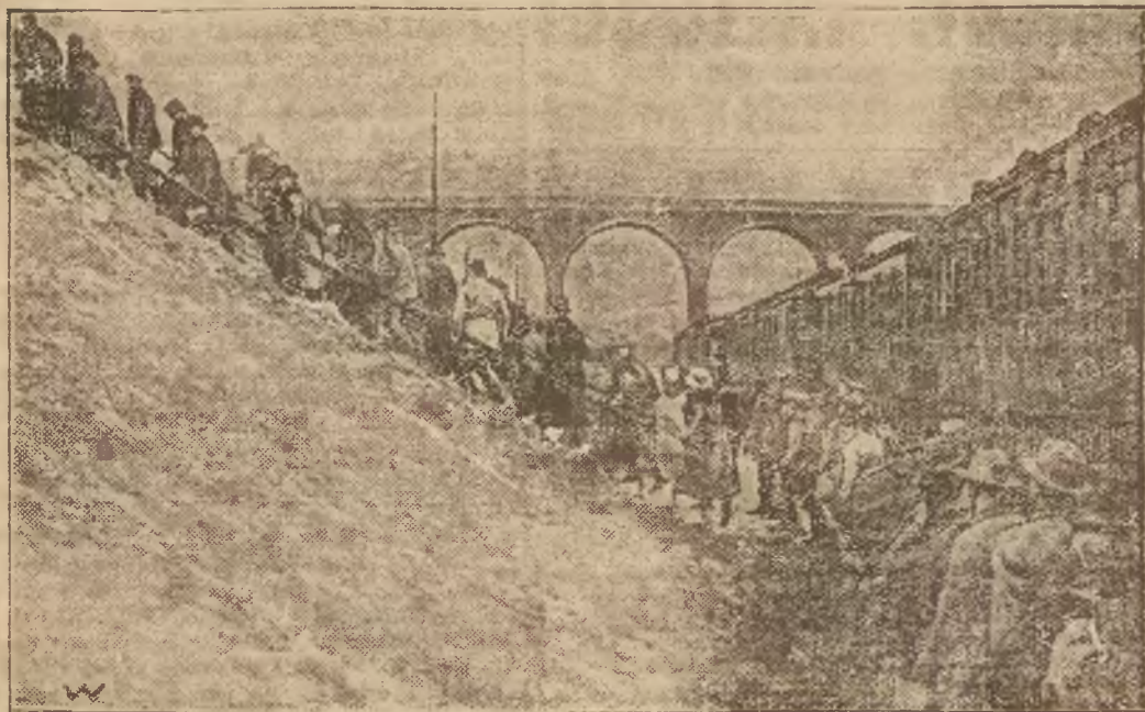
Na linii Berlin-Frankfurt przerwano niedawno komunikację kolejową wskutek osunięcia się nasypu kolejowego. Rycina nasza przedstawia zniszczony tor kolejowy i przesiadających się do innego pociągu pasażerów.
