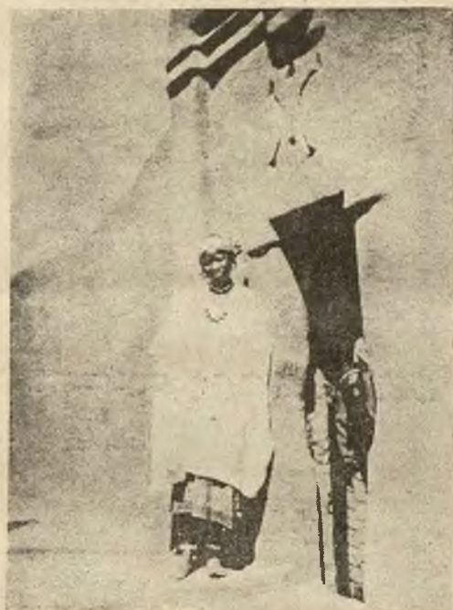
Z Sudanu: Oryginalna budowla w okolicy Tombouctu.
