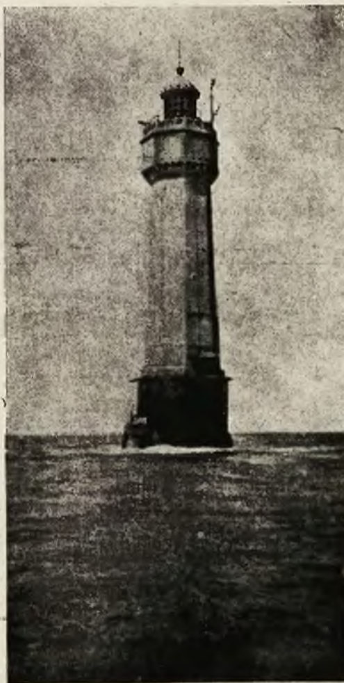
Latarnia na pękam morzu, zbudowana koło Jument przez francuskiego inżyniera Heurté.
