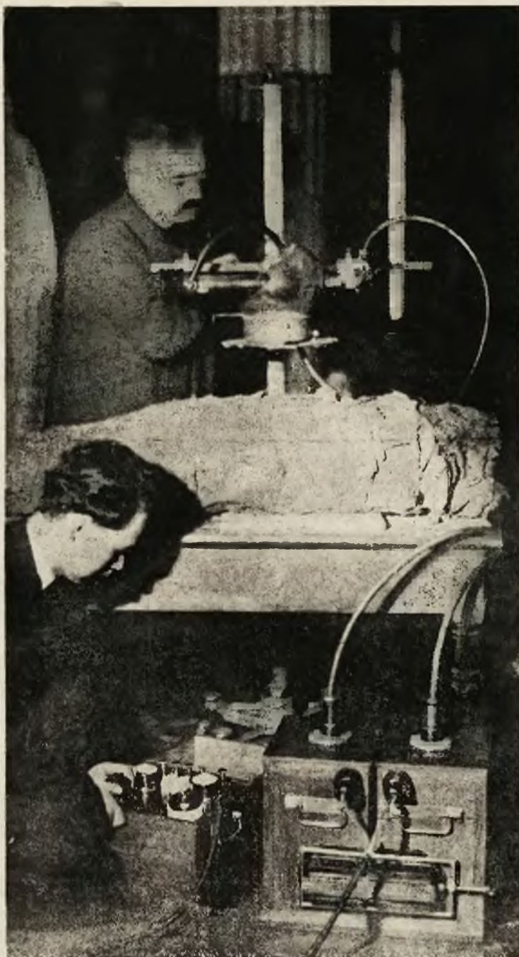
Badanie mumji przy pomocy promieni Roentgena w muzeum Guimet w Paryżu: Szkielet mumji (z przed kilku tysięcy lat) prześwietlony promieniami Roentgena i aparat Roentgena w czasie dokonywania zdjęć z mumji.
