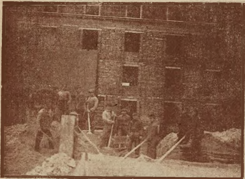
Młodzież technicka przy gaszeniu wapna.
