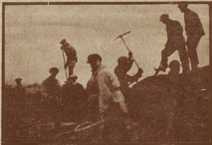
Wiosenne roboty ziemne przy niwelacji.
