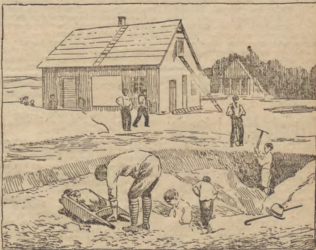
Młodzież technicka przy kopaniu rowów pod własny dom.
