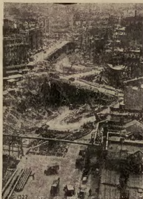
Rozbudowa kolei podziemnej w Nowym Jorku, w środku miasta, wzdłuż 6 Avenue.
