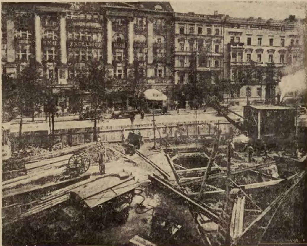
Z dworca prosto do kąpeli: Budowa tunelu, który łączyć będzie dworzec w Anhalt (Niemcy) hotelem „Excelsior“. Tunel prowadzi bezpośrednio do wielkich zakładów kąpielowych hotelu.
