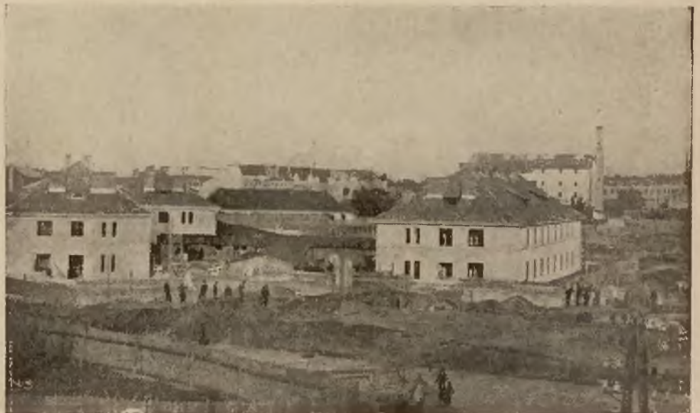
Widok budowy baraków dla dełożowanych przy ulicy Peltewnej i Granicznej, wznoszonych kosztem gminy miasta Lwowa: dziewięć budynków, każdy o 32 mieszkaniach jednoizbowych, ma być wykończonych do końca b. r.
