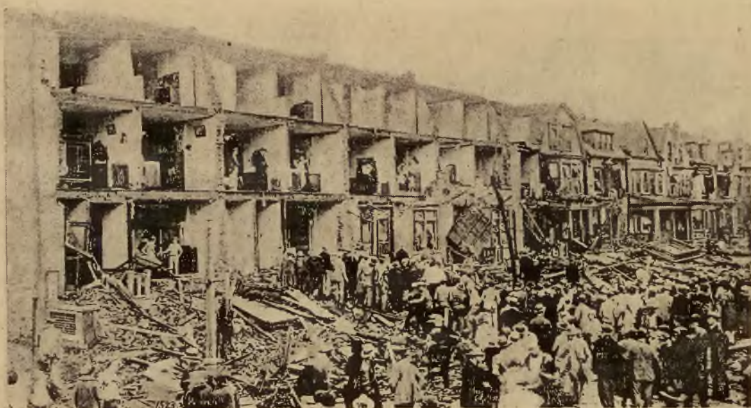
Katastrofa huraganu w St. Louis (Stany Zjednoczone): część ulicy z zburzonymi domami, których fasady zostały zupełnie zerwane przez burzę.
