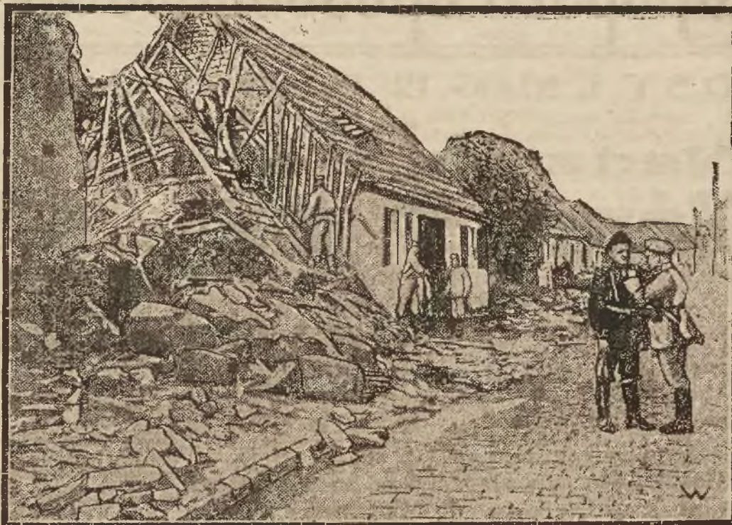
Przerwanie chmury w obszarze Mansfeld w Niemczech wyrządziło olbrzymie szkody. W celu naprawienia szkód musiano wezwać wojsko. Rycina nasza przedstawia zniszczone powodzią domu przy ulicy Fryderyka w Serbstädt w czasie prac ratunkowych pionierów.
