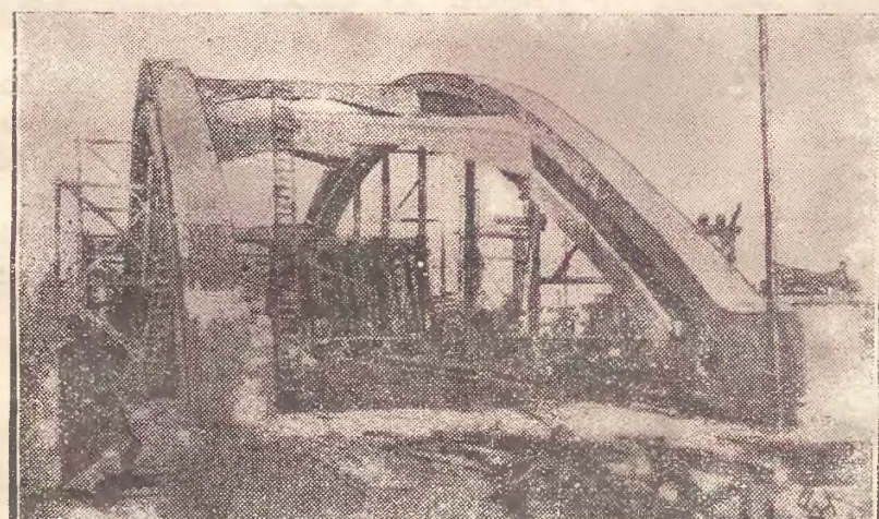
Na zdjęciu naszym widzimy wielki wiadukt żelbetowy, wybudowany na moło węglowym w porcie w Gdyni, przeznaczony dla ruchu kolejowego. Wiadukt oddany będzie do użytku z wiosną r. b.
