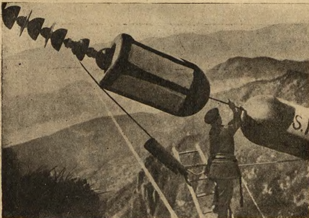
Olbrzymie izolatory, które zawieszono na łańcuchach na Monte Generoso celem chwytania piorunów i uzyskania w ten sposób olbrzymiego napięcia kilku milionów wolt.
