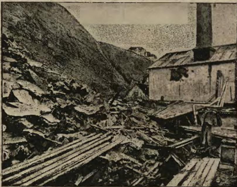
(xy) Gwałtowne burze, które szalały ostatnio na morzu Północnym i Bałtyckim, wyrządziły spustoszenia na wyspie Helgoland. Kruszące się skały zburzyły basen wodny i dwa sąsiednie budynki, jak to widzimy na naszej rycinie.
