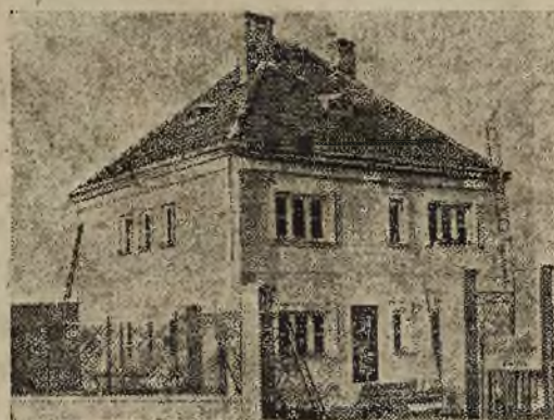
Typ domku jednopiętrowego ze stali, zbudowanego przez Tow. budowy tanich domów we Lwowie.
