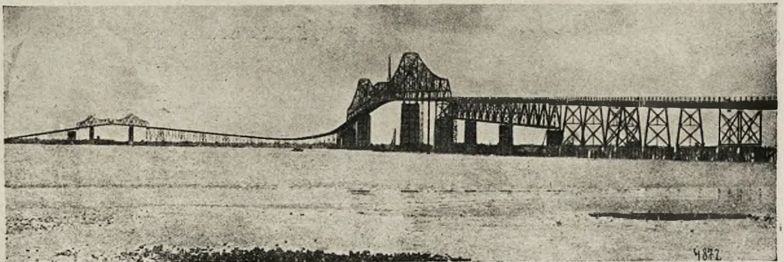
Most długości trzech kilometrów zbudowali Amerykanie w mieście Charleston.
