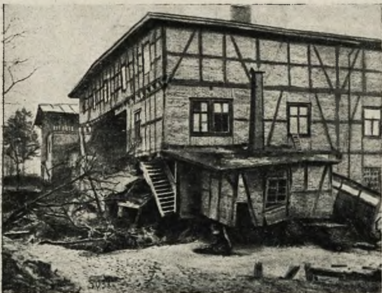
Katastrofa powodzi na Pomorzu: dom w miejscowości Strassfort, który runął do połowy, podmulony falami wezbranej rzeki.
