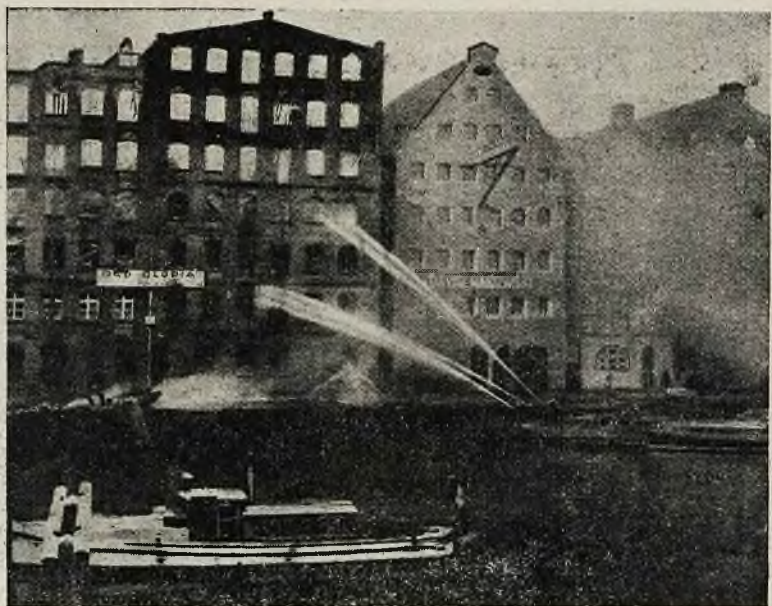
W Gdańsku spłonęły śpichlerze zawierające 5.000 ton zboża.
