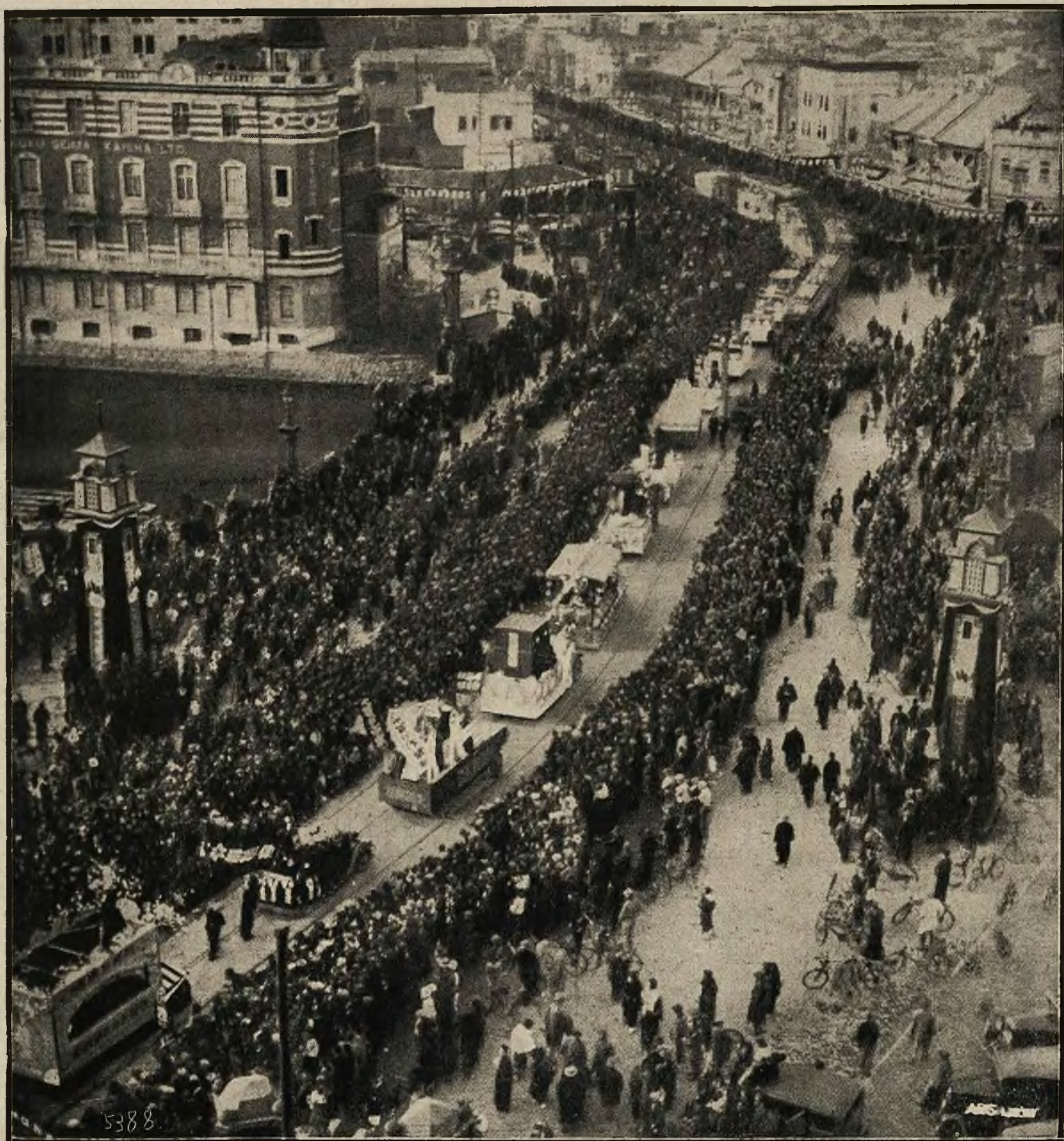
Japonja obchodziła niedawno święto swojej odbudowy po ostatnim strasznym trzęsieniu ziemi. Przez ulice stolicy Tokio przeciągnął orszak, złożony z odświętnie przystrojonych wozów. Rycina przedstawia orszak w chwili przebywania mostu Nihon-bashi, tworzący punkt-środkowy stolicy.
