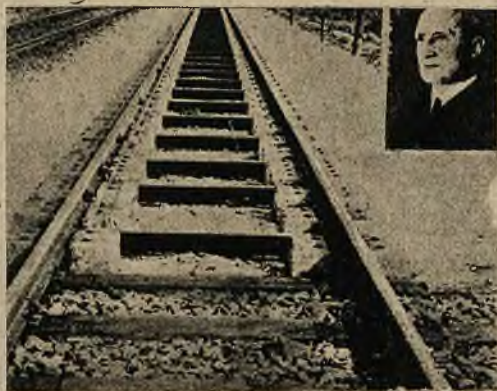
Wyłazek usuwający wstrząsy wozów kolejowych podczas jazdy: szyny otoczone są w obu stron ciężkimi kamiennymi ramami, wyrównującymi miejsca spawów.
