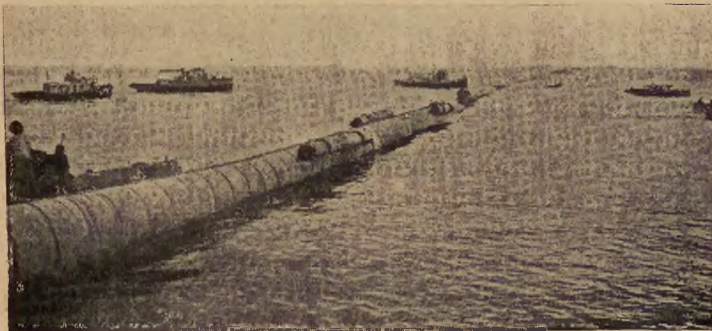
Inżynier francuski Jerzy Claude zamierza schwytać przy pomocy olbrzymich rur, zanurzonych w morzu, podmorskie prądy Golf-Streamu dla wykorzystania ich do produkcji siły elektrycznej. Oto budowa rury na północnym wybrzeżu Kuby.
