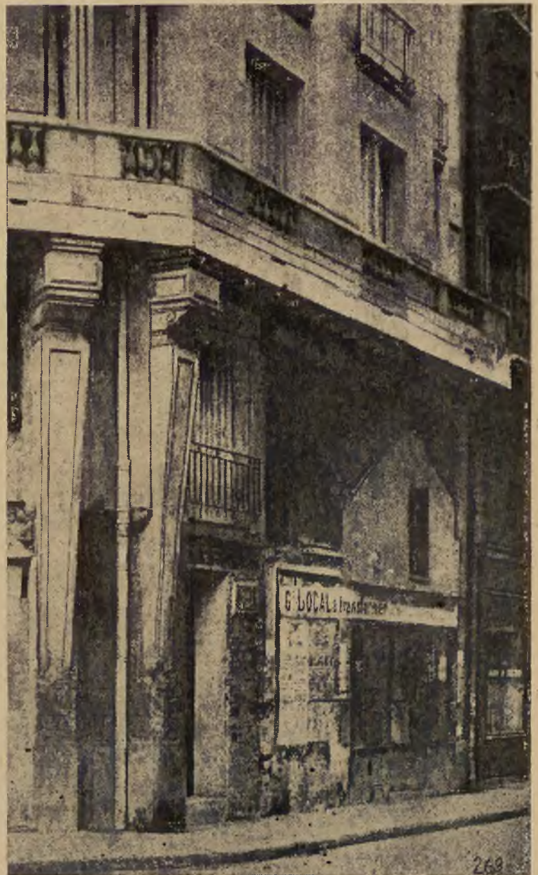
W jednej z dzielnic Paryża wzniesiono nadbudowę na starym domu, którego właściciel nie chciał opuścić.
