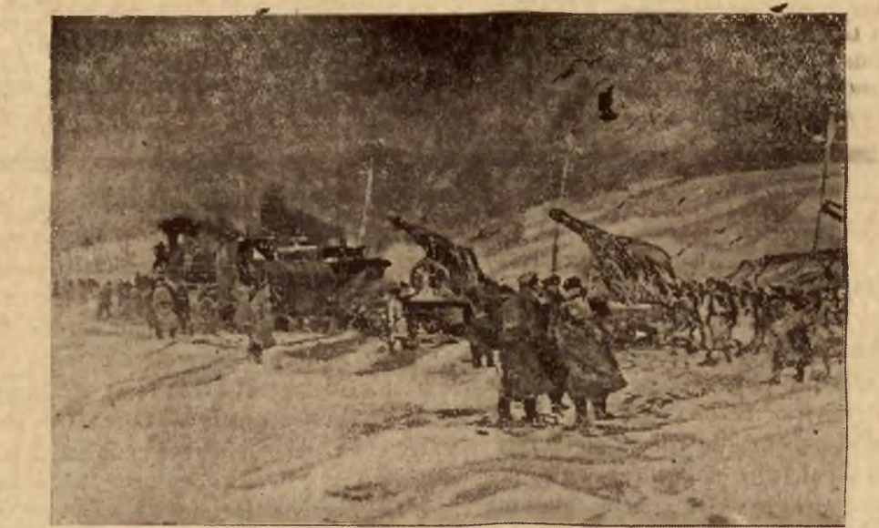
Pociąg wiozący baterję portową, zaskoczony przez zamieć na kolei Mandżurji
