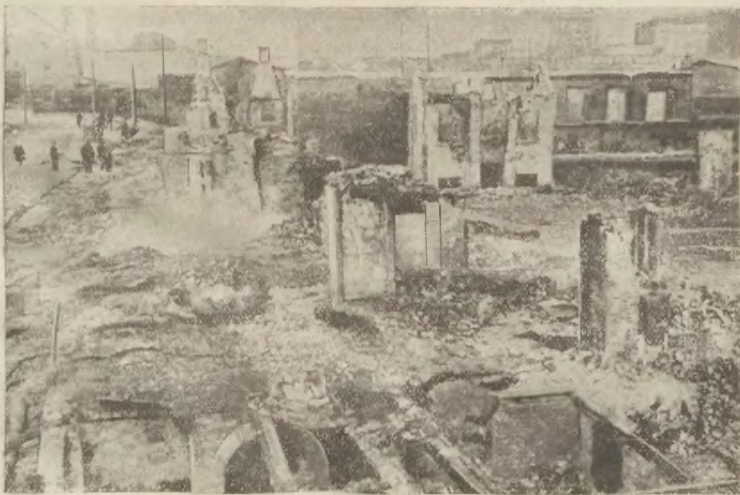
Ruiny spalonych domów na jednej z ulic w Windawie na Łotwie, gdzie część miasta padła ofiarą płomieni.
