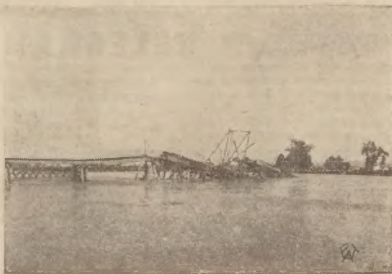
Jeden z zerwanych mostów w kolejowych pod Krakowem.
