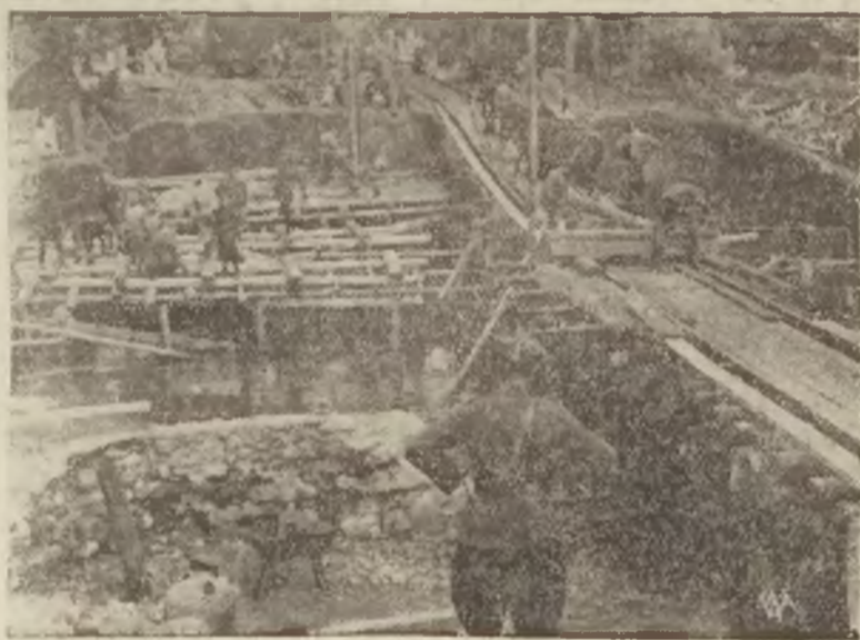
Saperzy przy budowie mostu w Bogumiłowicach, gdzie wskutek powodzi przerwana została komunikacja.
