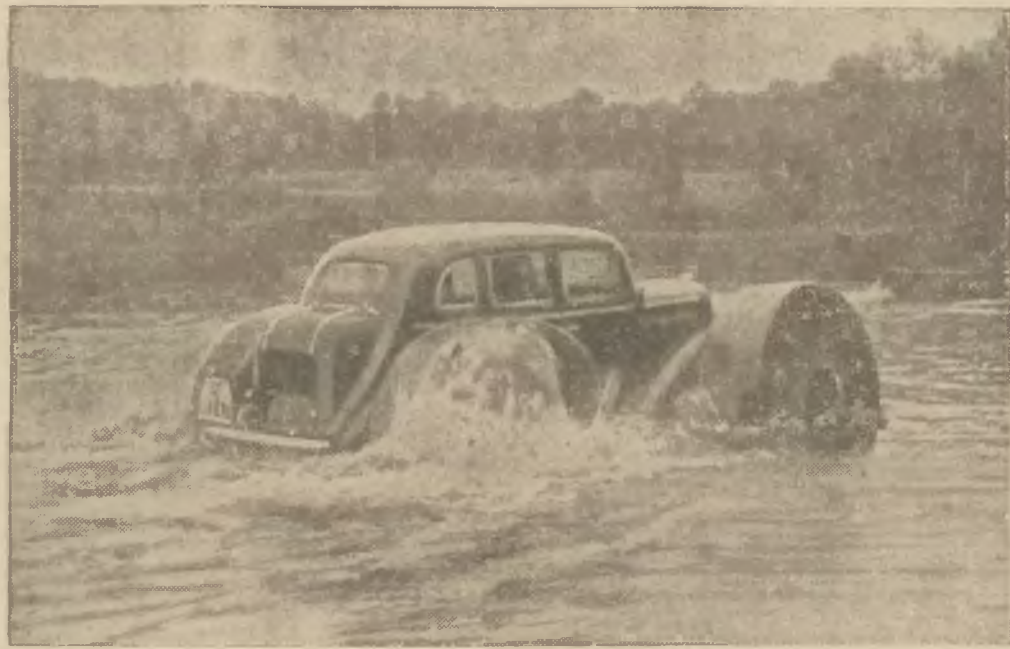
Problem samochodu lądowego i wodnego rozwiązywano już wielokrotnie bez większego powodzenia. Na uwagę zasługuje ostatni wynalazek obywatela Kolonji Waltera Bodensteina, który zaopatrył zwykłe auto w kola pontonu. Wóz osiąga w wodzie szybkość 20 km. na godzinę.
