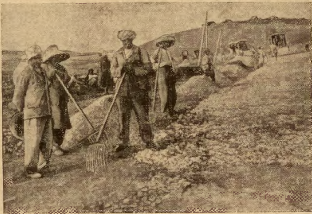
Zarząd Tunisu dąży wytrwale do poprawy stosunków komunikacyjnych, przez budowę szos i połączeń telegraficznych.
